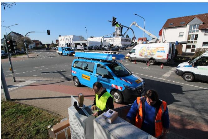
**Abb. 1** Im Projekt »KI4LSA« soll Künstliche Intelligenz eine intelligente, vorausschauende Ampelschaltung ermöglichen. Hochauflösende Kamera- und Radarsensorik erfasst das Verkehrsgeschehen präzise.
